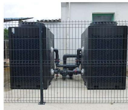
Avant l'ouverture de la piscine le 17 juin, des travaux de mise aux normes et de remise en état étaient nécessaires. L'entreprise Le Teuff a poursuivi les travaux de carrelage autour du bassin, deux pompes à chaleur ont été installées par l'entreprise Aqua-tech d'Ablis dans le 78 en remplacement du réchauffeur. Une bâche thermique servant au maintien de la température de l'eau a également été installée. Le coût total de rénovation de la piscine s'élève à 250 000€.
