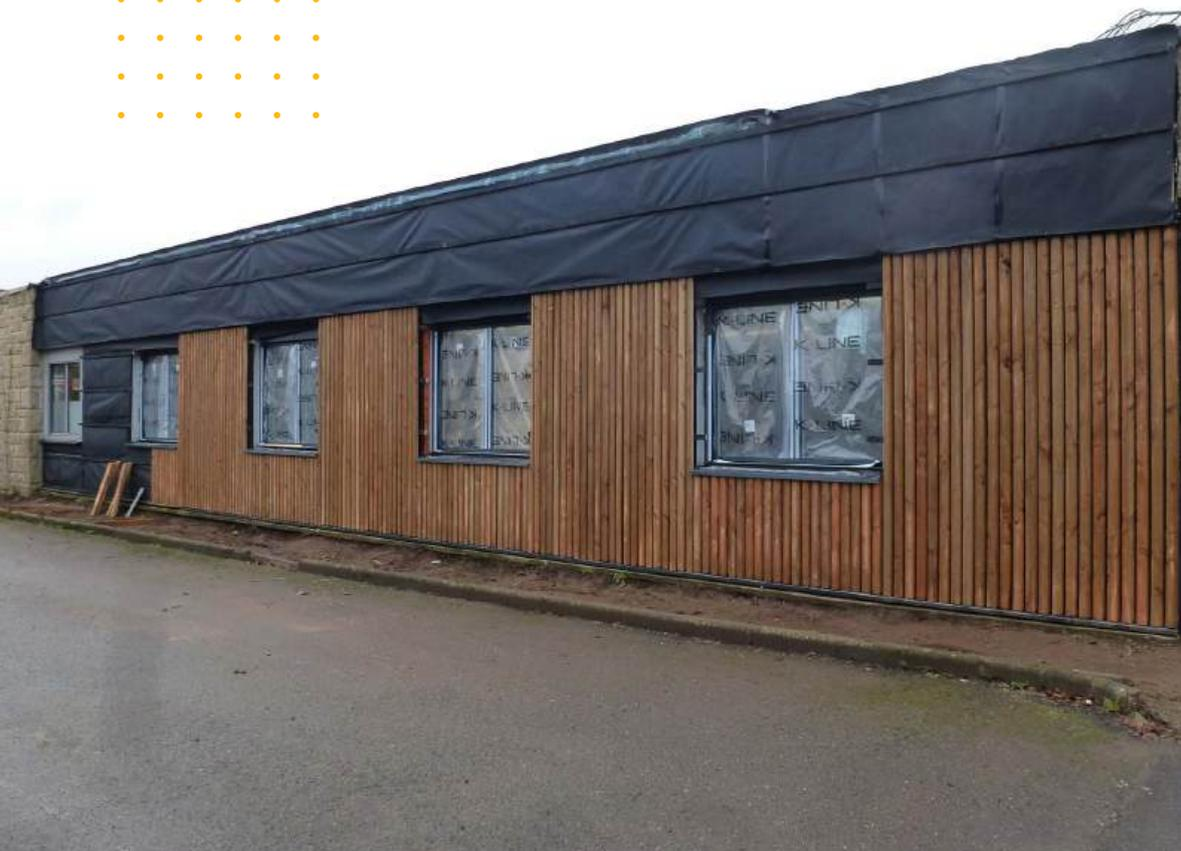
*L'entreprise pleybérienne Renobois a remplacé toutes les anciennes menuiseries, ajouté une isolation extérieure ainsi qu'un bardage bois. L'aménagement intérieur est en réflexion et sera réalisé, cellule par cellule, par les Services techniques communaux.*
